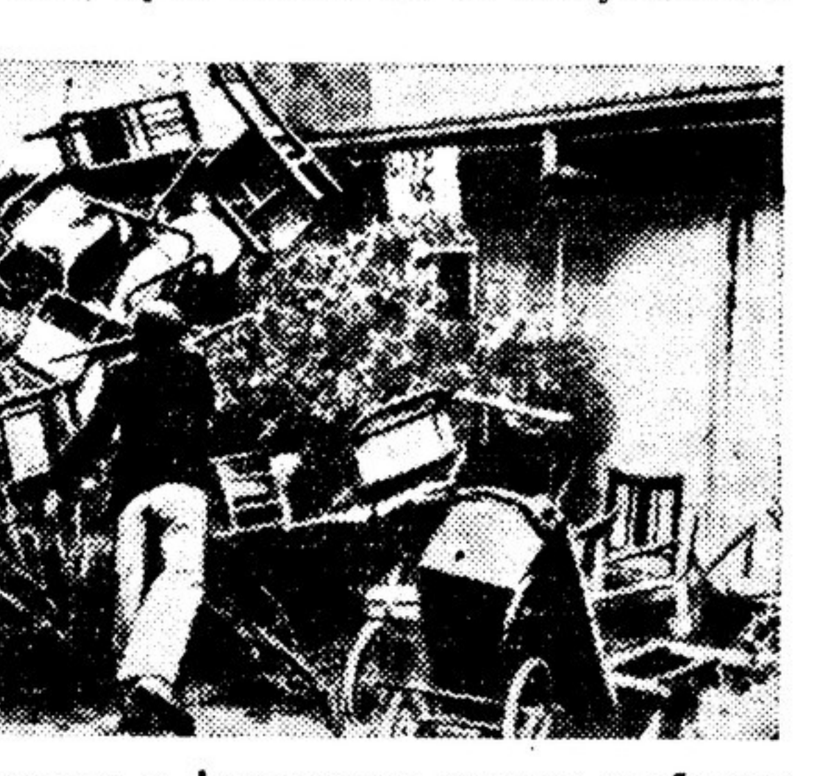
Эмигрантов, приезжающих в Австралию в поисках хлеба насущного, встречают безработица, дороговизна, жилищная, устроенные в заброшенных сараях, служивших ранее складами шерсти... Впрочем, и эти каморки недоступны для безработных. У них нет средств оплатить даже такие «квартиры», и полиция безжалостно выселяет их на улицу. На фото: эмигранты строят баррикады на дороге, чтобы помешать полицейским выселить их семьи. Нались гласит: «Третьем справедливости».
